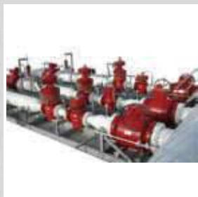
Stacje redukcyjne i pomiarowe
